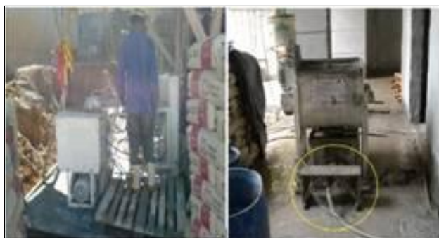
Figura 2 - Detalhe dos degraus para trabalhar com os misturadores
